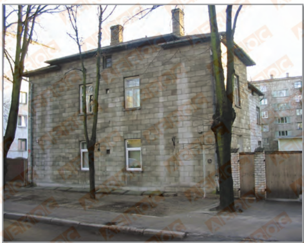
Рис. 1. Здание из автоклавного газобетона без наружной отделки. 1939 г.п., г. Рига, ул. Эльвирас, 15
