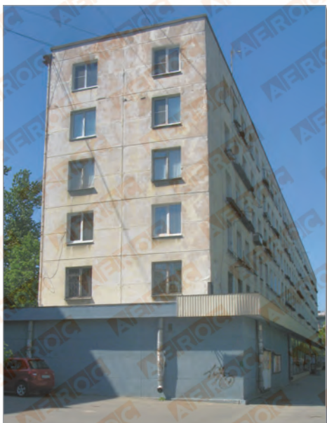
Рис. 2. Здание из автоклавного газобетона, 1960-е. Санкт-Петербург, Краснопутиловская, 45.
