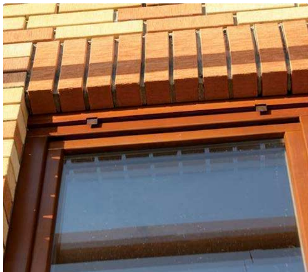
Внешний вид кладки с использованием перемычек BRICKO
