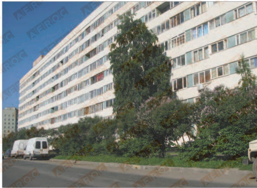
Рис. 3. Наружные стены из автоклавного газобетона. «Корабль», 1970-е, Санкт-Петербург.
