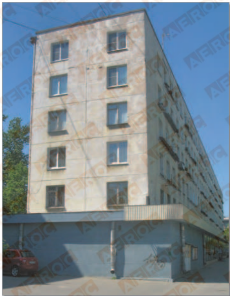
Рис. 2. Здание из автоклавного газобетона, 1960-е. Санкт-Петербург, Краснопутиловская, 45.
