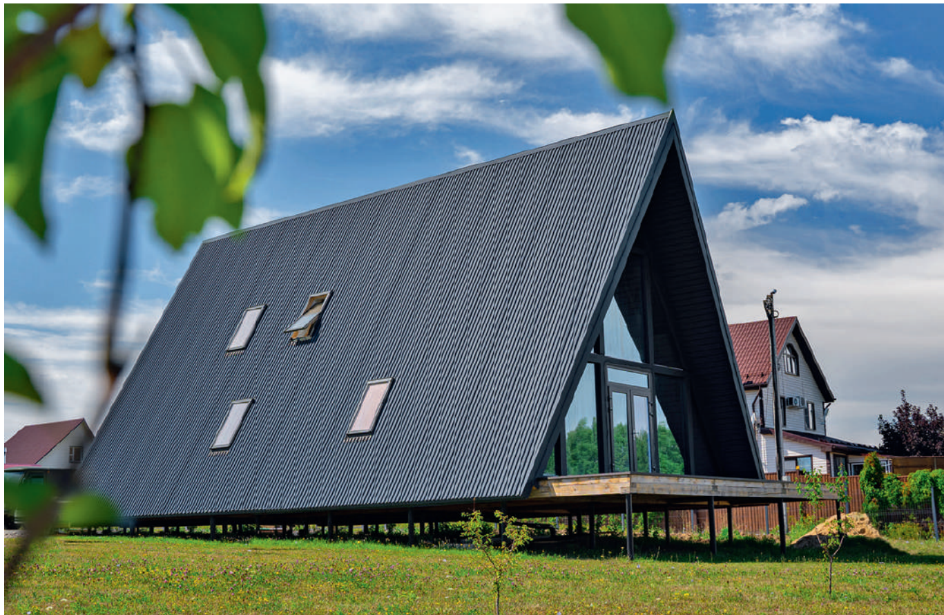
Профнастил C21R в покрытии Drap TX, RAL 7024
