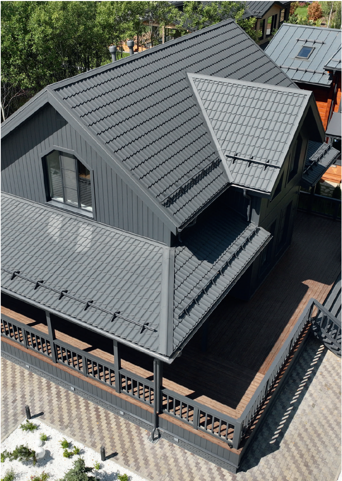
Металлочерепица Классик в покрытии Satin Matt TX, RAL 7024 Снегозадержатели Grand Line, RAL 7024
