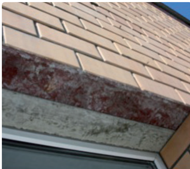
Внешний вид кладки без применения перемычек BRICKO
