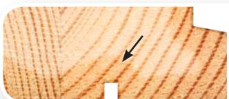
**Пропитка древесины в вакууме и лаковое покрытие** обеспечивают защиту деревянных элементов окна для крыши FAKRO. Пропитка древесины в несколько раз надежнее и качественнее, чем просто погружение.
