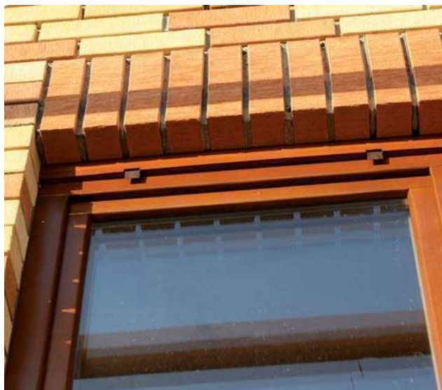
Внешний вид кладки с использованием перемычек BRICKO
