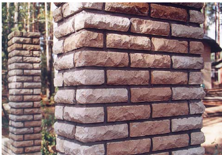
Ограда Для производства опор использован белый и коричневый фактурный полнотельный силикатный кирпич производства Павловского завода СМ
