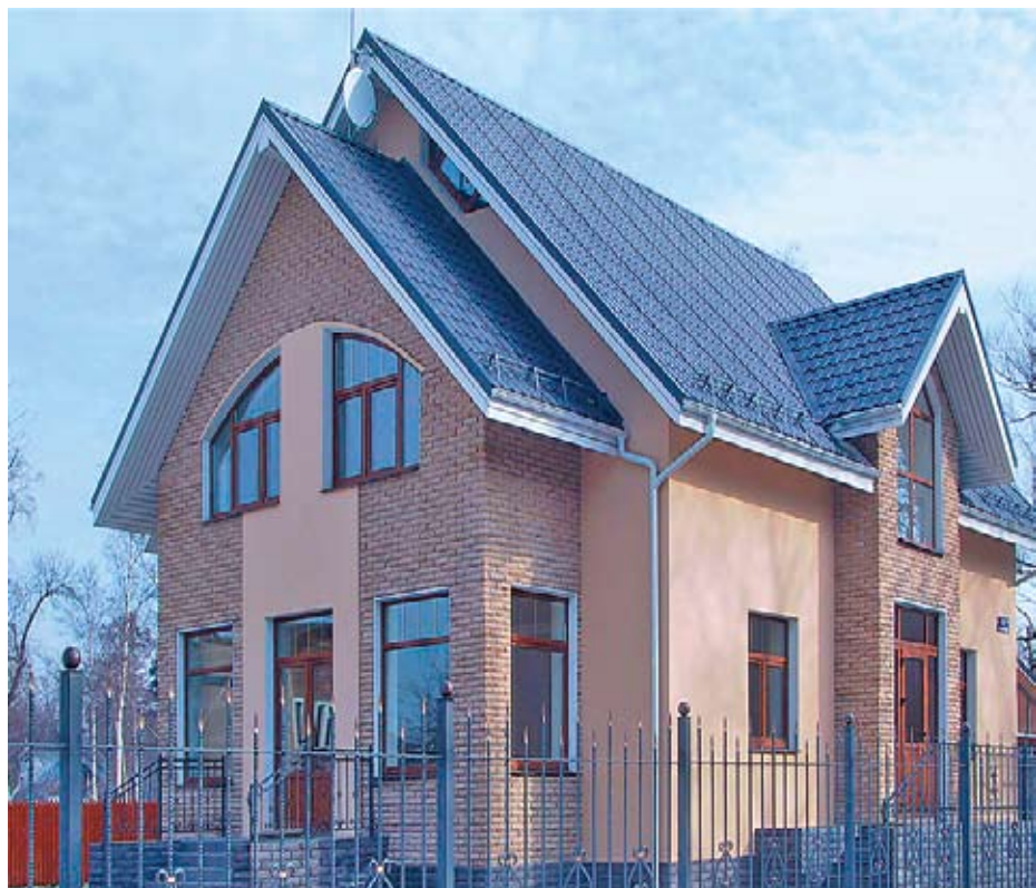
Коттедж Годы постройки: 2000-2003 Стеновая кладка: жёлтый фактурный полнотельный силикатный кирпич производства Павловского завода СМ
