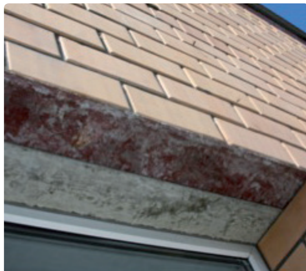
Внешний вид кладки без применения перемычек BRICKO
