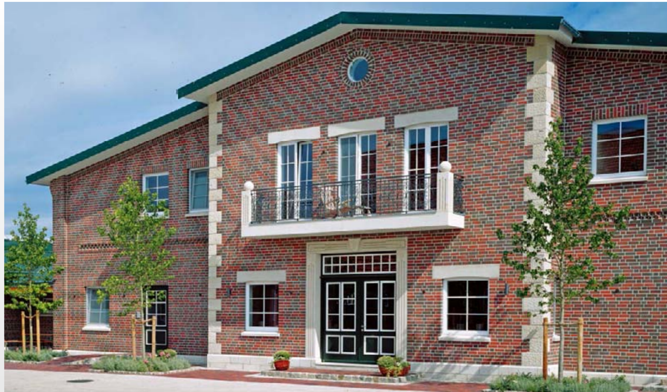
Gestütswohnhaus in Lemwerder/Weser Planung: Alfons Brüggehagen, Molbergen
