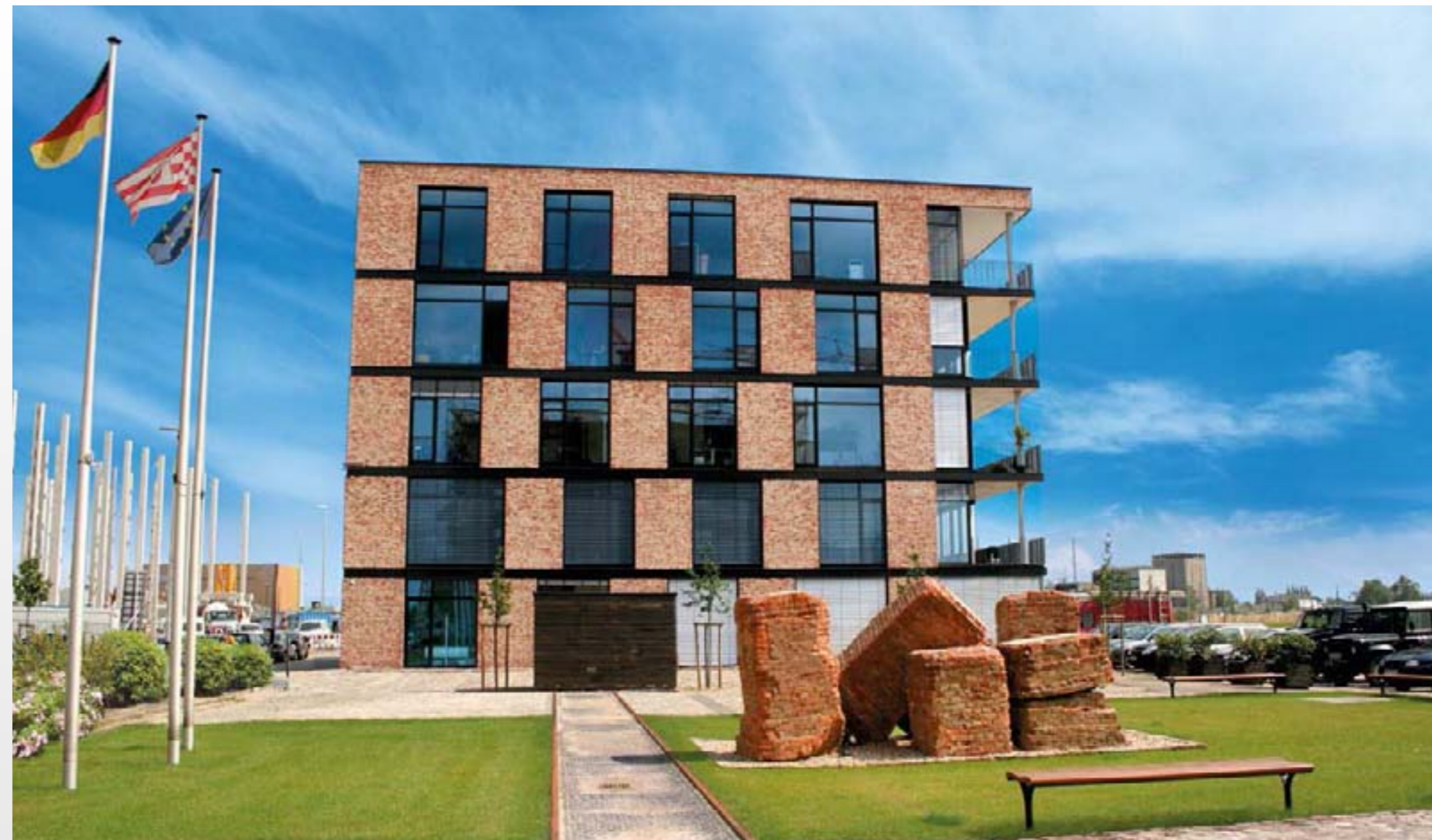
Bürolofts in der Bremer Überseestadt Planung: Hilmers Lamprecht Architekten, Bremen
