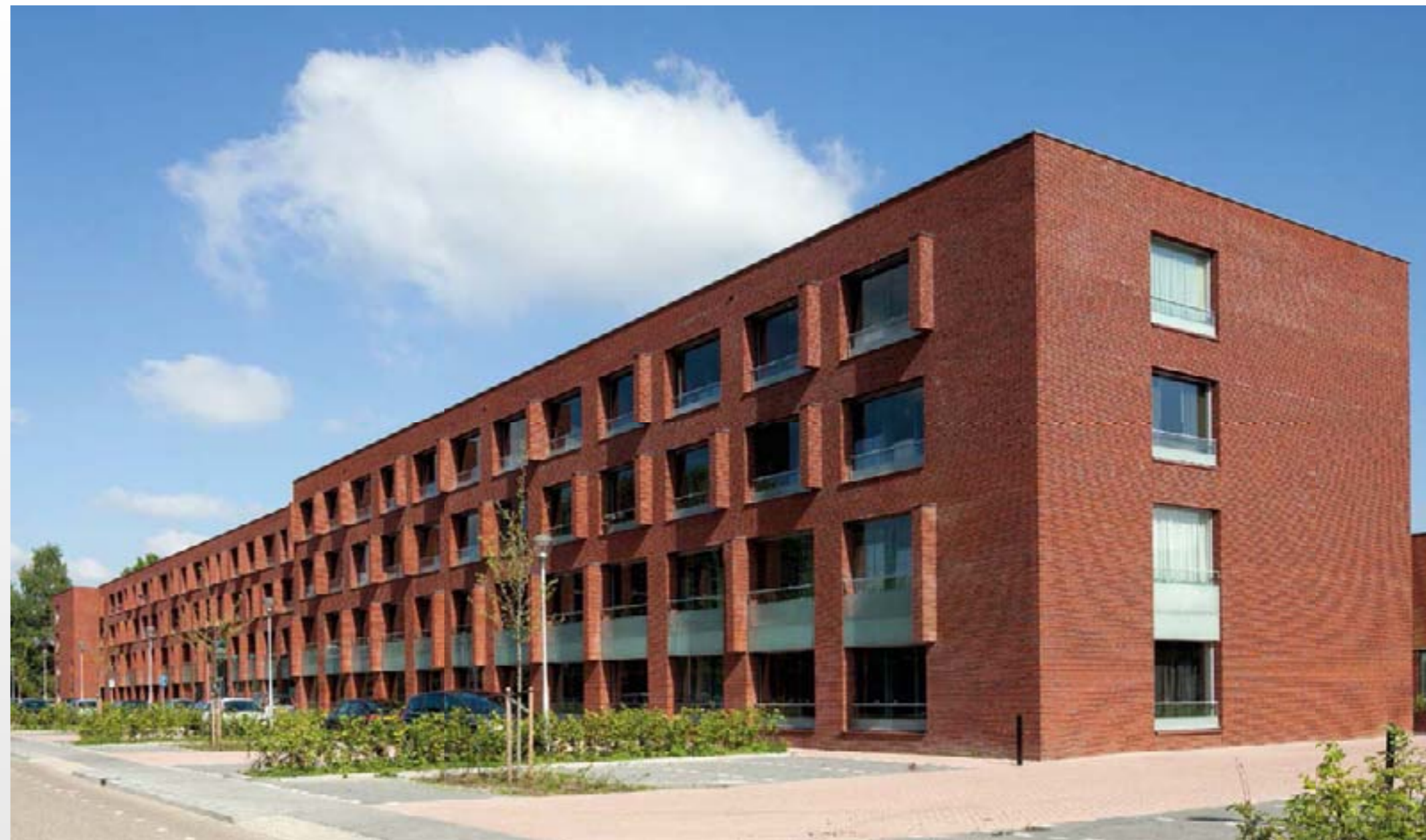
Wohngebäude in Tilburg (NL) Planung: Jacq. de Brouwer, Peter Kejsers, Goirle (NL)
