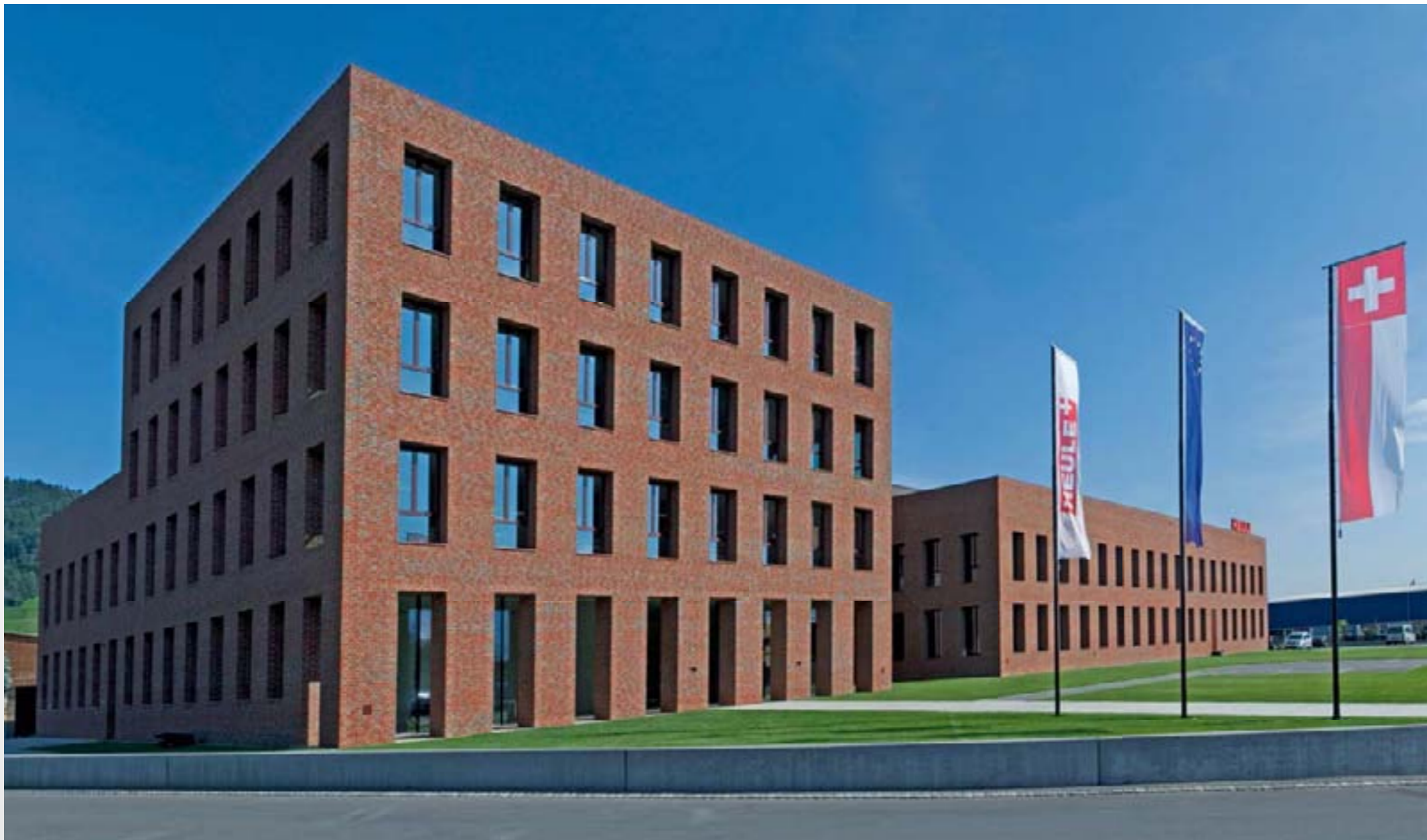
Produktionsgebäude in Balgach (CH) Planung: Baumschlager Eberle Architekten, Lochau (A)
