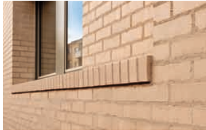
Bündig abgezogene, nicht zusätzlich verdichtete Mörtelfugen.
