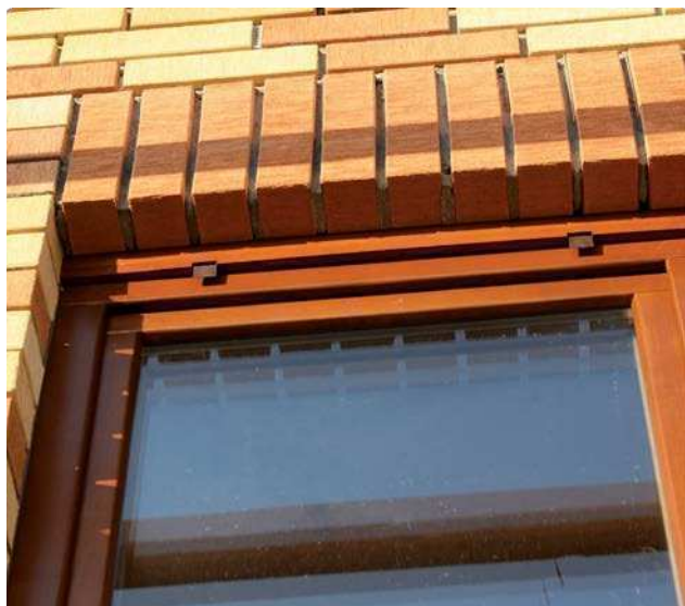
Внешний вид кладки с использованием перемычек BRICKO
