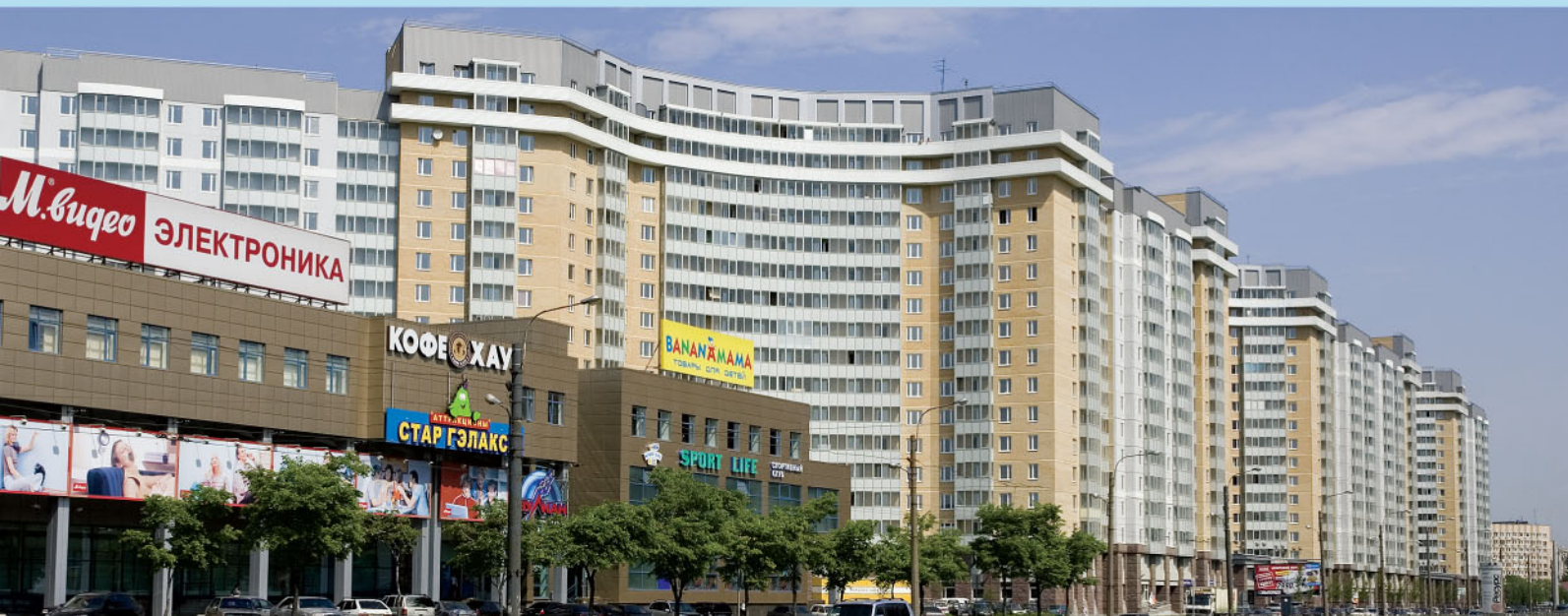
Для облицовки фасадов использован жёлтый пустотелый кирпич Павловского завода СМ
