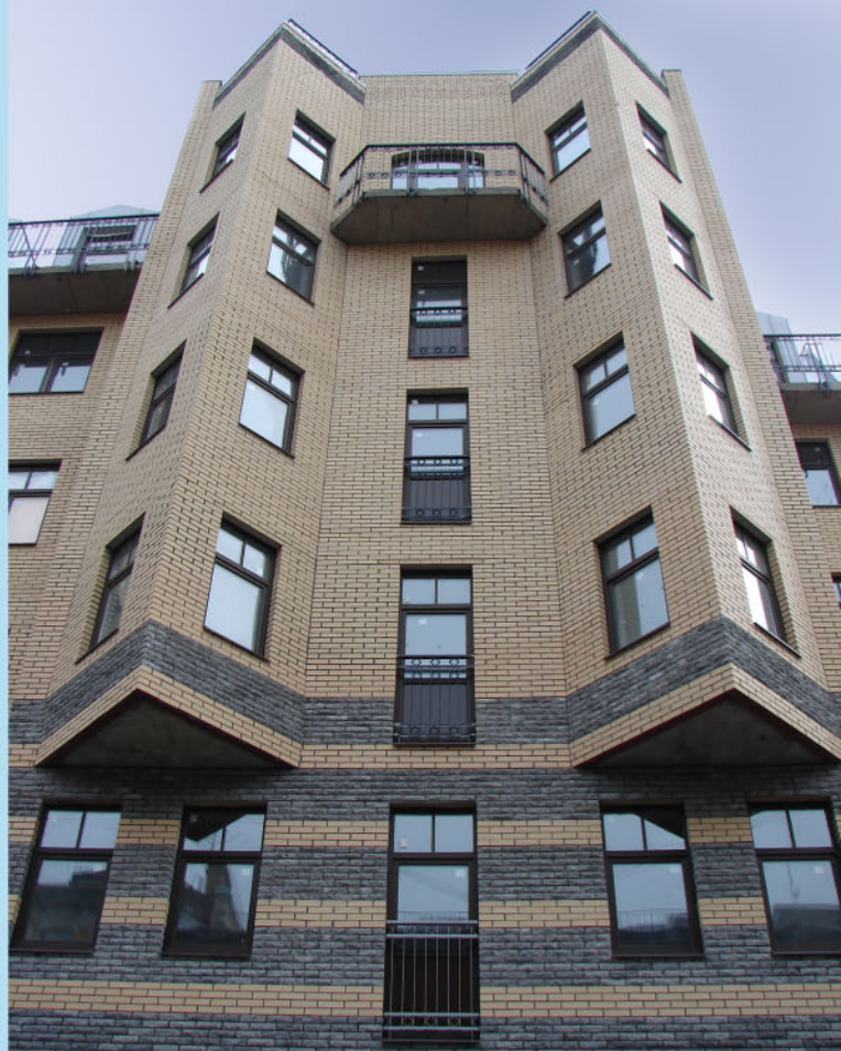
Для отделки фасадов использован пустотелый кирпич зелёного цвета, а также белый и коричневый фактурный кирпич Павловского завода СМ
