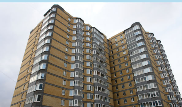
Для облицовки фасадов использован жёлтый пустотелый, а также фактурный кирпич цвета габбро Павловского завода СМ
